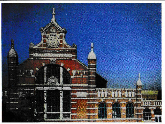
Generatorenhalle Viersen (Bj. 1905)
