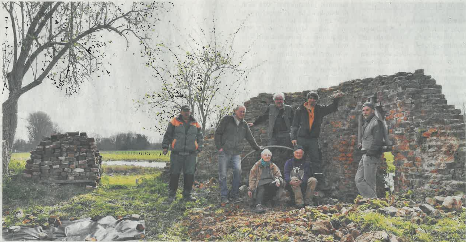
Der Erhalt der alten Wasserburg liegt vielen am Herzen. Bei den Sanierungsarbeiten helfen unter anderem (v.l.) Uli Döhmen (Nabu), Bernhard und Ludwig Mertens, Milan Prior (Nabu), Restaurator Antonius Kiwall sowie (sitzend) Architektin Inge Breidenbach und Günter Wessels (Nabu).
